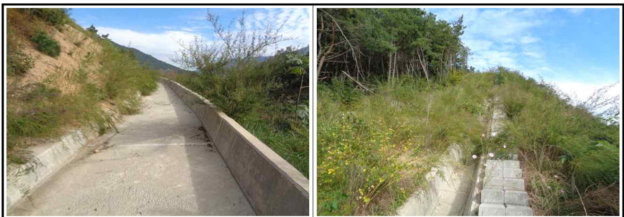
【그림 11.3.3】 배수시설 전경
